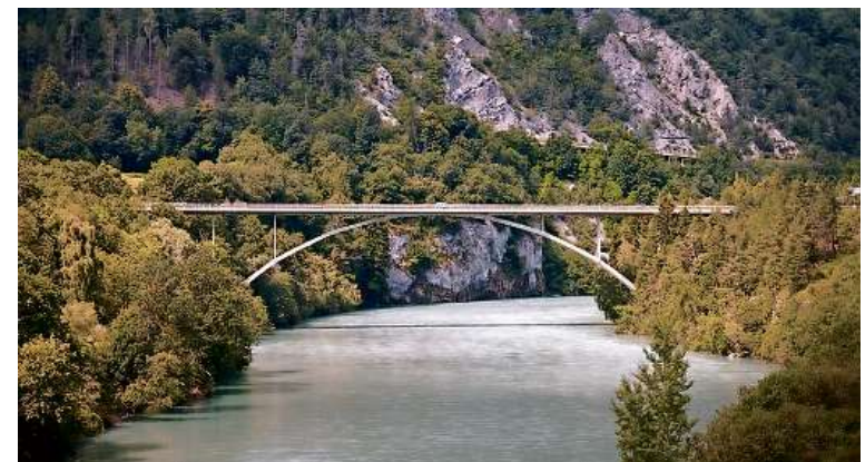
1963 erbaut: Christian Menns Rheinbrücke bei Tamins setzt an landschaftlich empfindlicher Stelle trotz ihrer Grösse einen ästhetischen Akzent. Bild Ralph Feiner
